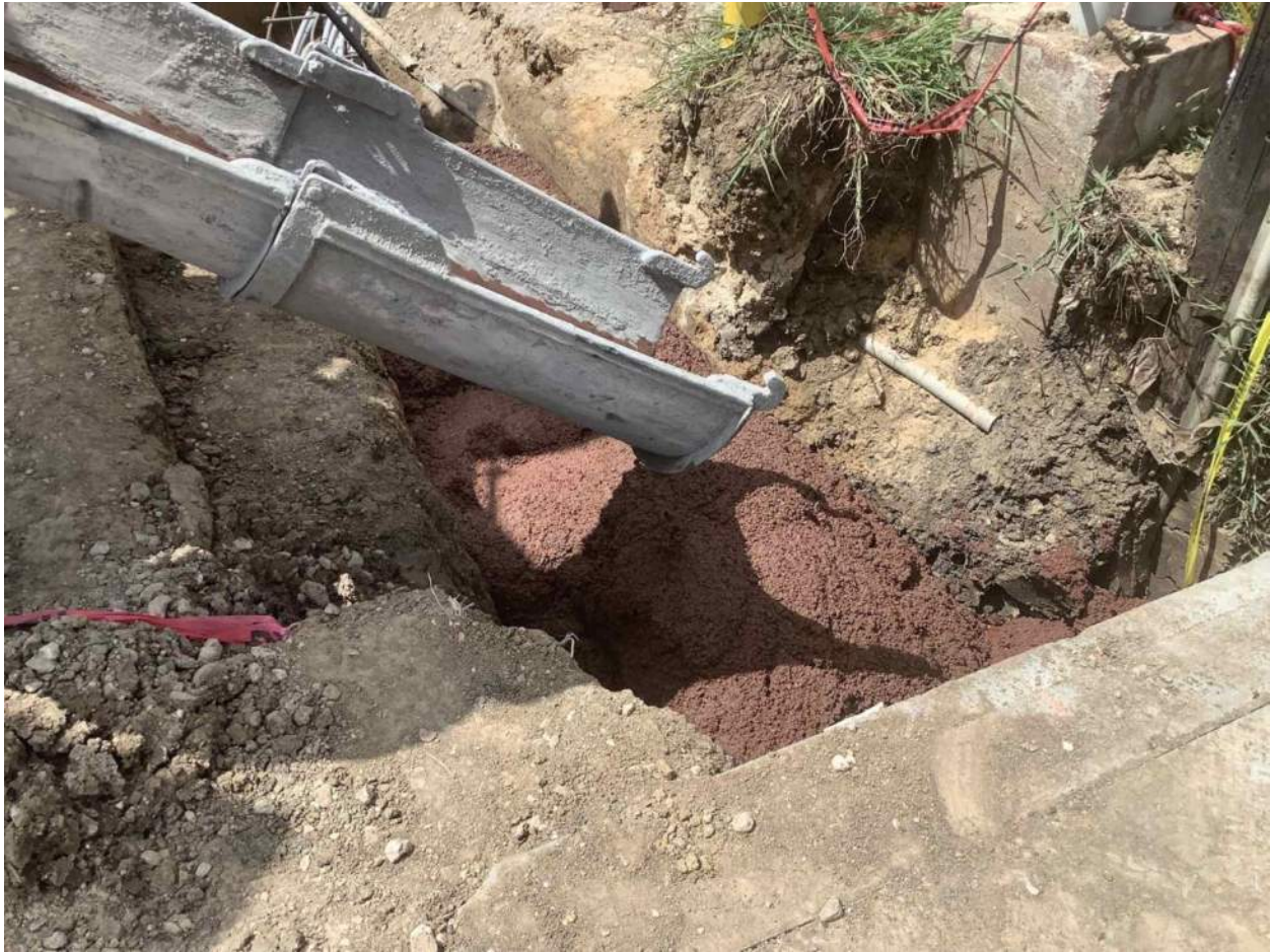
Red concrete pour for ductbank
