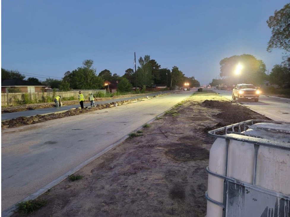
Early morning sidewalk pour east of Stone Rd.
