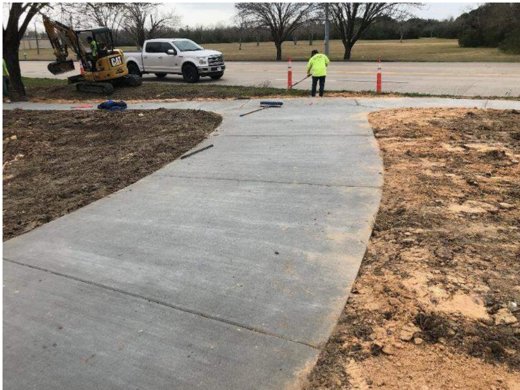
Final concrete pour at FM 518
