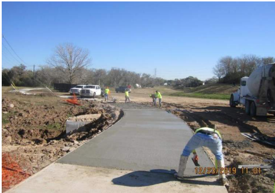
Concrete pour over storm boxes
