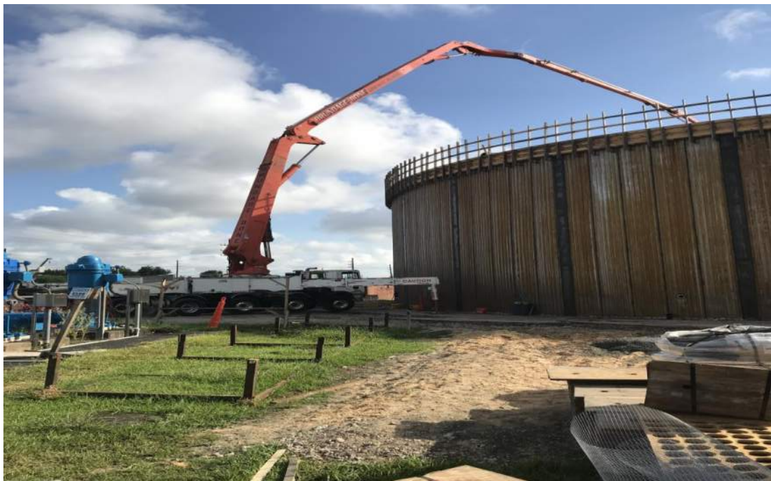
Concrete pump truck to pour dome ring
