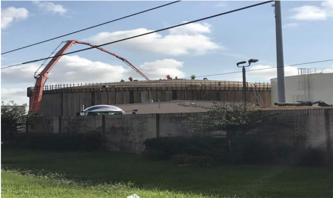
Concrete pump truck to pour dome ring
